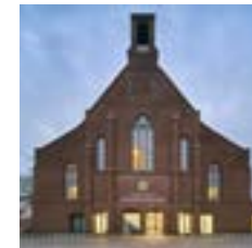
Borne 15 ProsperVastgoed BV Gezondheidscentrum De Poort van Borne Reitsemā & partners architects
