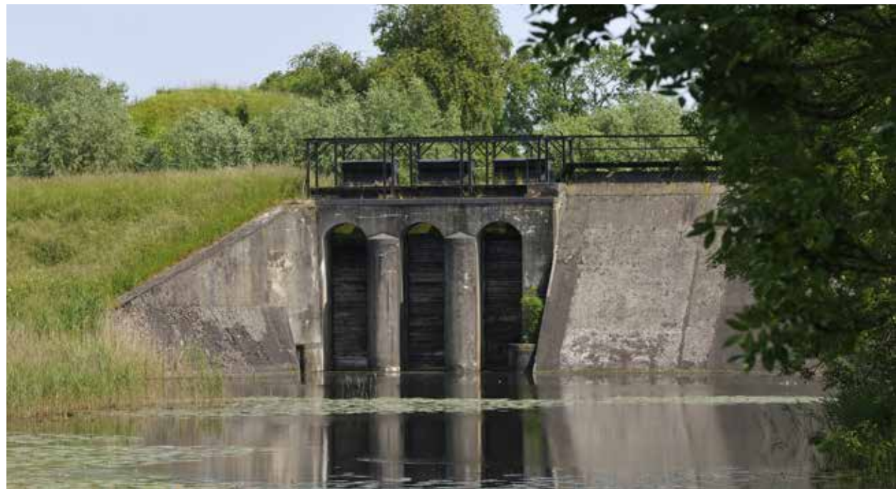
beersluis bij Fort bij Everdingen
